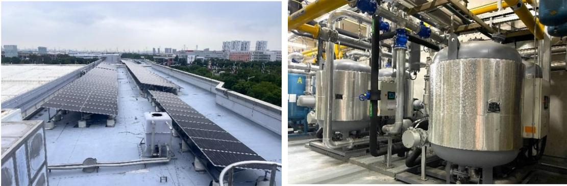
图 1：光伏项目（左）、空压系统节能技改（右）
