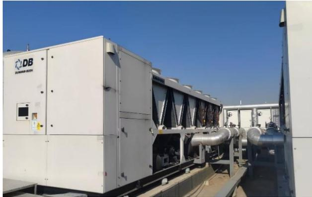
图 3：风冷四管制多功能型空调机组
