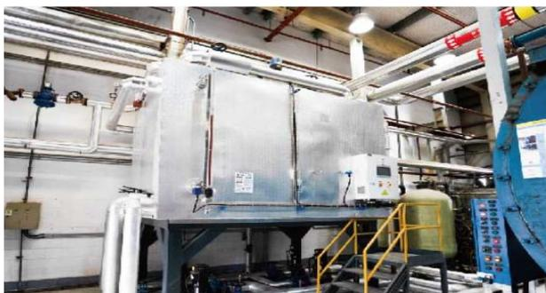
图 4：除氧水箱更换改造
