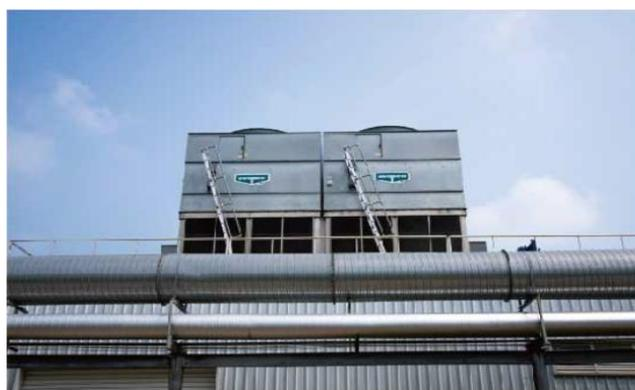
图 6：冷却塔代替冷水机组项目
