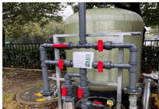
图 4：雨水过滤储罐
